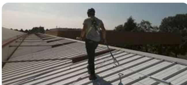
Camminamento in copertura
